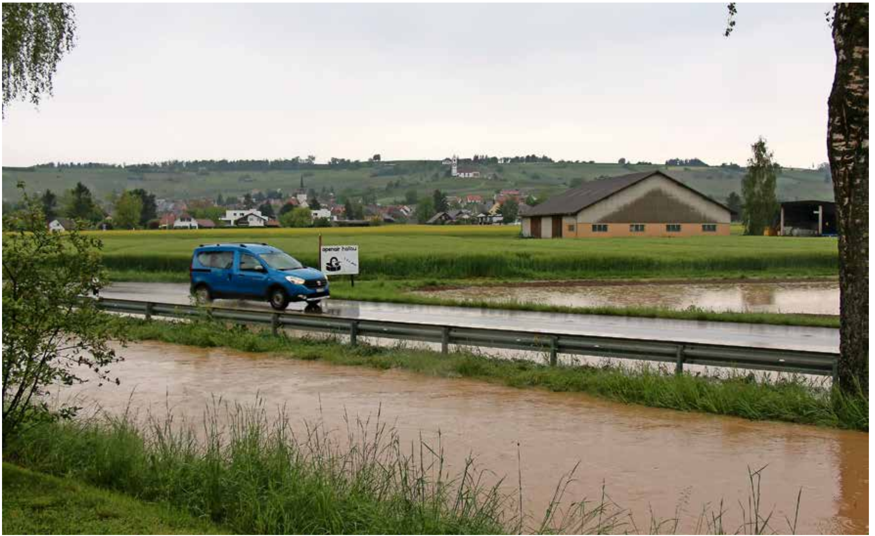
Beidseits der Neunkircherstrasse hiess es in Hallau am Samstagnachmittag «Land unter».
